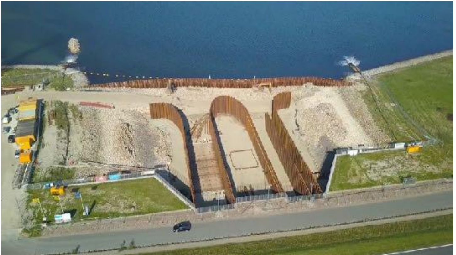
Aanleg stroomgoten testcentrum (foto: BT Projects)
